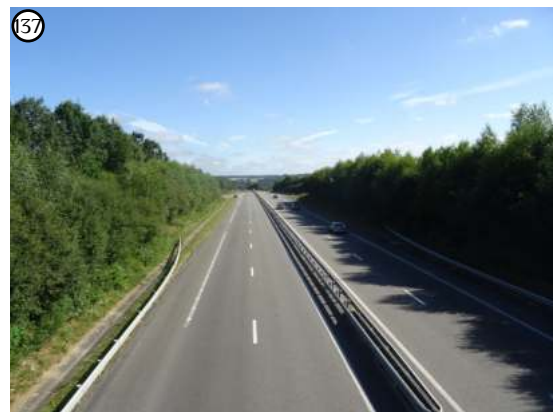
137 A20 vue en direction du Sud : la voie est calée entre deux hauts talus végétalisés
