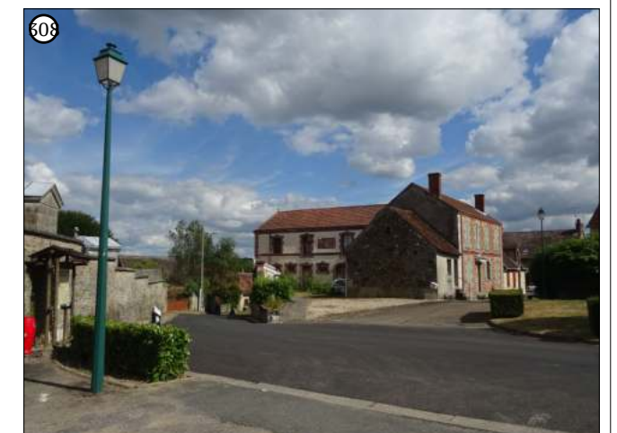
Cette photo montre l'amorce de la descente vers la vallée depuis le village de Beaulieu
