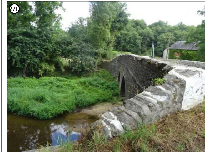
Franchissement historique au niveau de la vallée de la Gartempe
